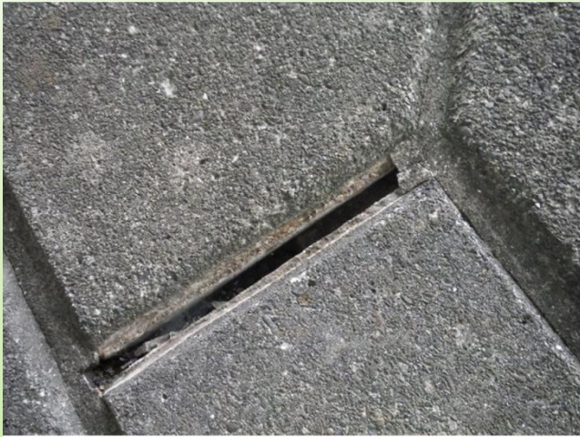
◇目視（変状・劣化）
