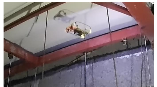
天井内調査状況
