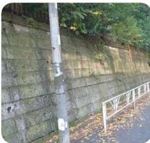
▲大谷石積み擁壁
