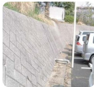
▲間知ブロック積み擁壁
