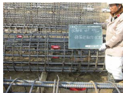
主筋への鉄筋計の取り付け状況
