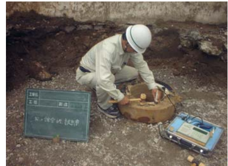
写真-1 測定例（既製杭）
