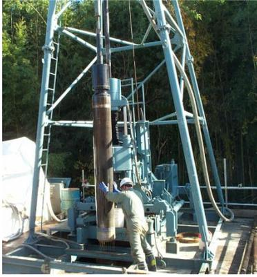
砂礫の採取（採取試料径 φ300mm）
