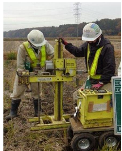
写真-1 全自動試験機の作業状況
