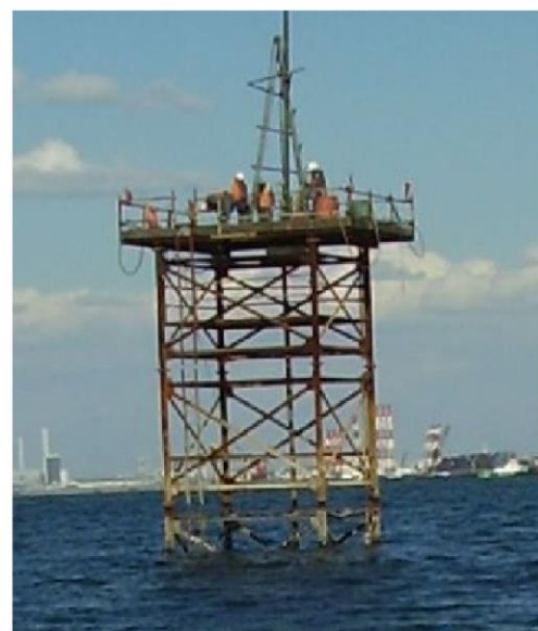
海上ボーリング(鋼製檣)
