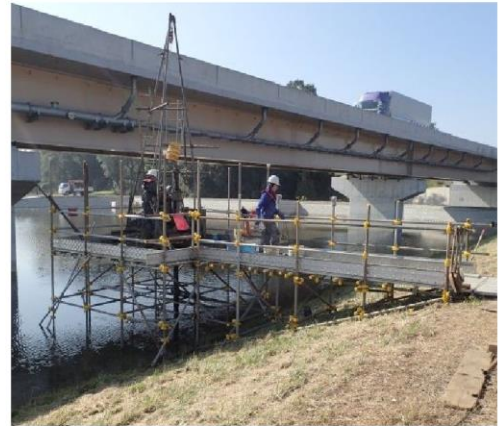
水上ボーリング(単管足場・栈橋)
