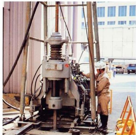
オイルフィードタイプによる調査状況
