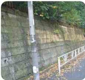
▲大谷石積み擁壁
