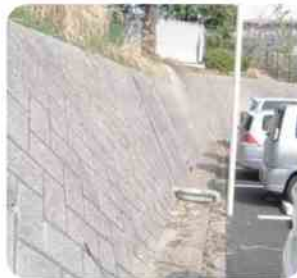
▲間知ブロック積み擁壁
