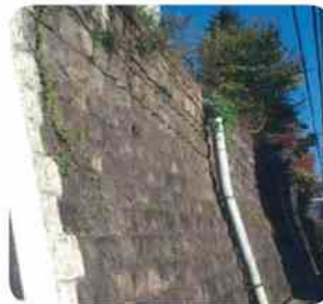
▲間知石積み擁壁
