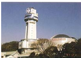
地震被災建物の復旧・補強 (明石市立天文科学館)
