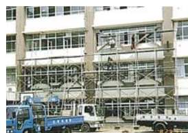
鉄骨ブレース補強 (稲城市立稲城第三小学校)
