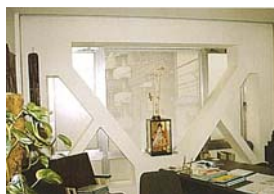
鉄骨ブレース補強 (東京日仏学院)
