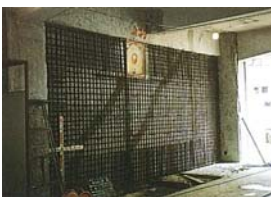
耐震壁の増設
