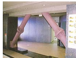
網管ブレース補強
