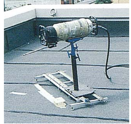
X線による配筋調査
