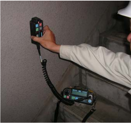
鉄筋探知器による配筋調査（１）
