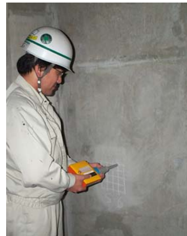
非破壊による強度測定
