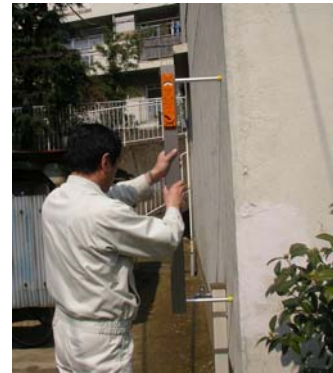
傾斜計による建物の傾斜測定
