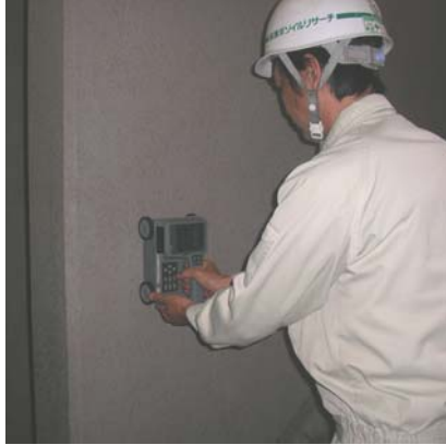
鉄筋探知器による配筋調査（２）
