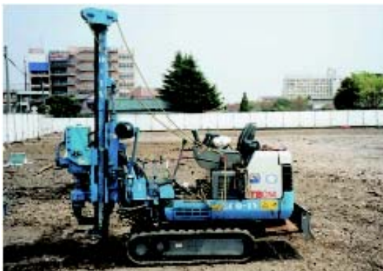
深度方向調査用ボーリングマシン
