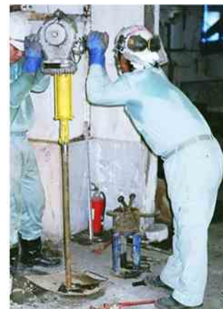
簡易ボーリングマシン
