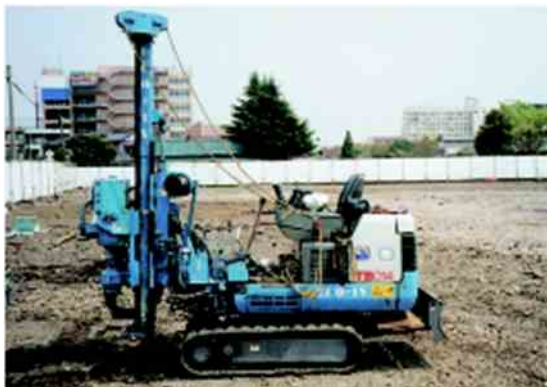
深度方向調査用ボーリングマシン
