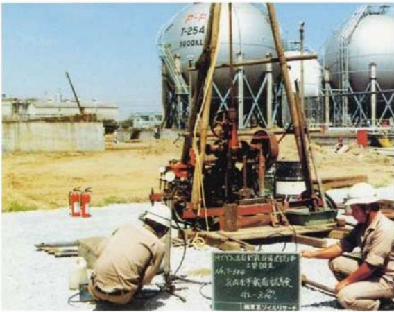
必要に応じて原位置試験を行います (孔内水平載荷試験実施状況)
