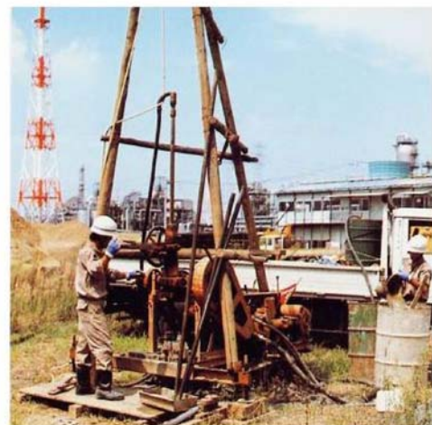
ハンドフィードタイプによる調査状況
